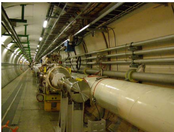
Obr. 3. CERN 2008 - Urýchľovač LHC (V mieste detektora ALICE (A Large Ion Collider Experiment). Dĺžka kruhového tunela je 27 km a je v priemernej hĺbke 100 m pod zemou. (Foto J. Štelina, fotoaparát PRAKTICA). (Pozri aj schematický obr. 6)
